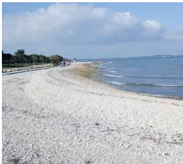
Slika 3: Nasip lomljenog kamenog materijala
