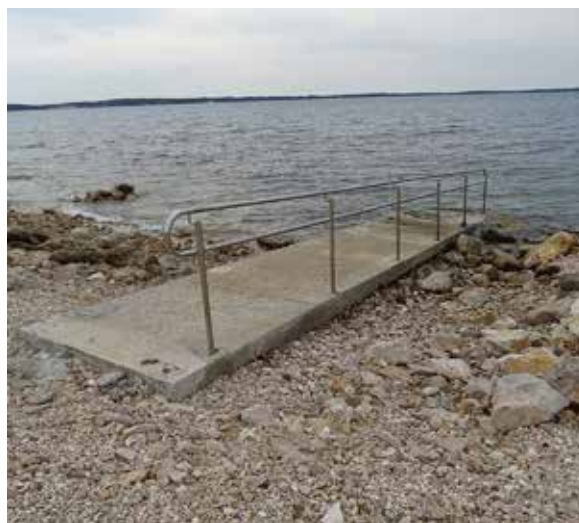
Slika 10: Rampa za ulaz u more
