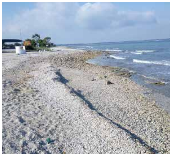
Slika 4: Nasip lomljenog kamenog materijala
